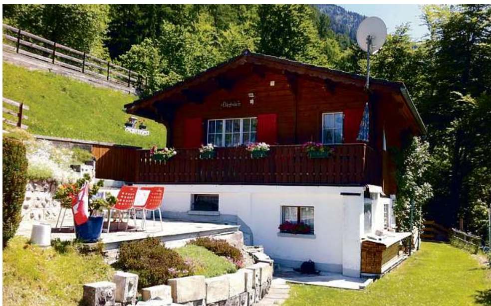
Baute oder Anlage ohne Bewilligung. Die kommunale Baubehörde ist für die Anordnung der Wiederherstellung zuständig. Bild zVg
